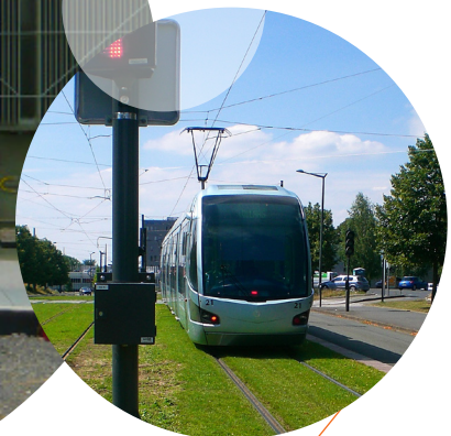
Diverses rénovations tramway - Nantes - Montpellier - Orléans - Valenciennes (2015 - en cours)
