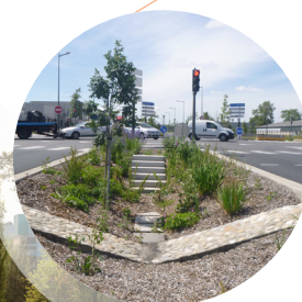
Aménagement du boulevard urbain nord à Lyon (69) (2007-2013)
