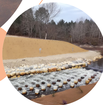
Aménagement passe à poissons du pont du gouvernement Courant de Ste Eulalie (40) (2018-En cours)
