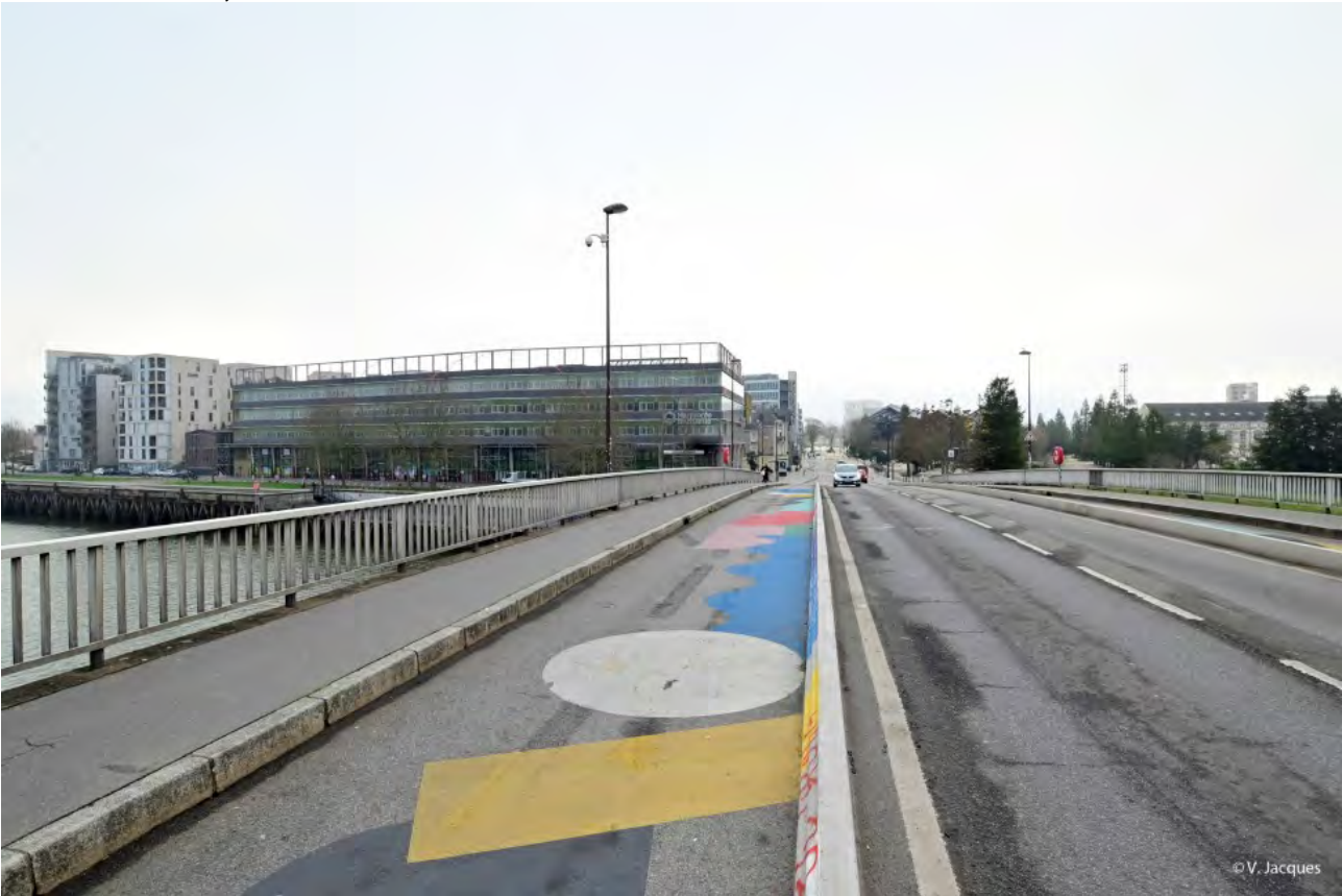
LE PONT-PLACE, VUE VERS LE BOULEVARD LÉON-BUREAU
